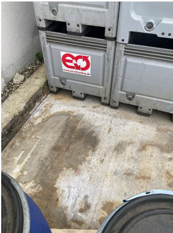
Abb. 1: Erodierte AwSV-Fläche
