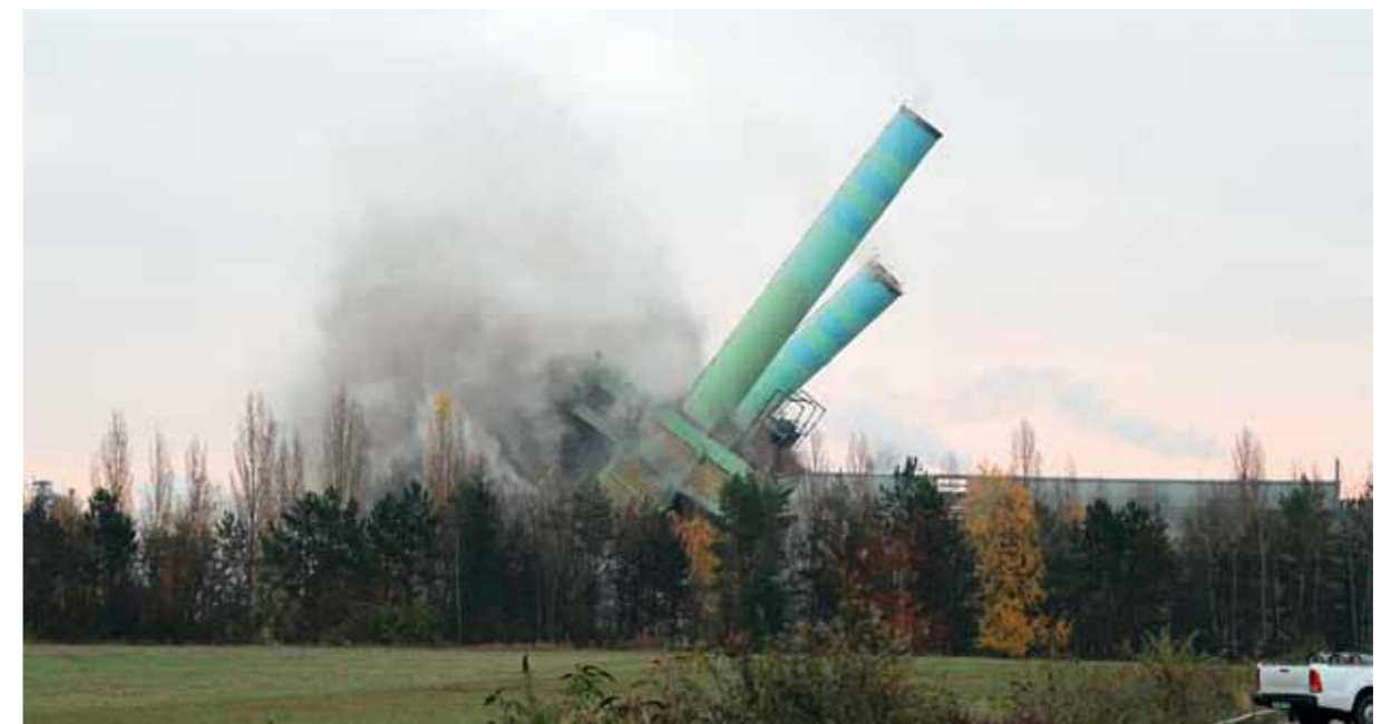
Wärmetauscherturm fällt aufgrund der Sprengung (Quelle: SGD Süd)
