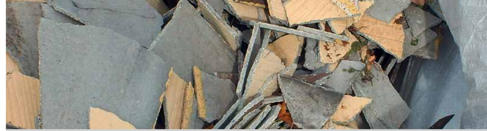
Asbestplatten (Bildquelle: SGD Süd)
