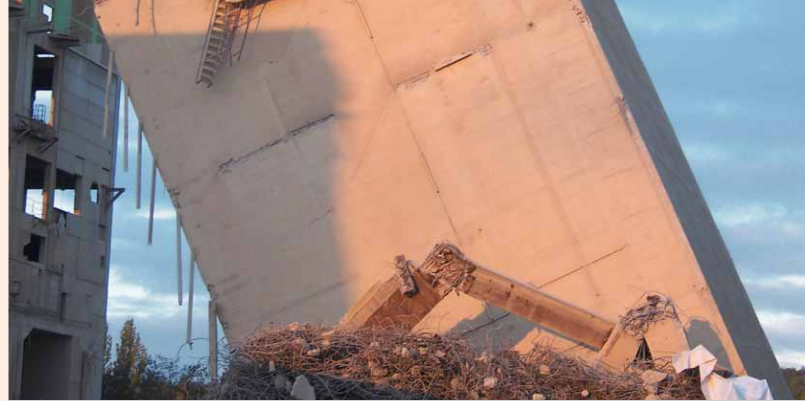
Das Silogebäude bleibt in einem Winkel von 45° liegen (Quelle: SGD Süd)
