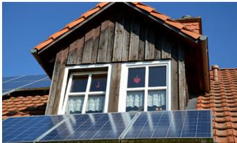
typischen Einfamilienhauses haben Aufdachanlagen eine Größe von 21 - 50 m<sup>2</sup> und eine Leistung von 3 - 5 Kilowattpeak (kWp). Als Kilowattpeak bezeichnet man die höchstmögliche Leistung einer Solaranlage unter Normbedingungen. Generell kann man pro kWp mit einer Fläche von 7 - 10 m<sup>2</sup> und Kosten von etwa 1400 - 1500 Euro inklusive Installation rechnen (Hinweis: Preise unterliegen Marktschwankungen).
