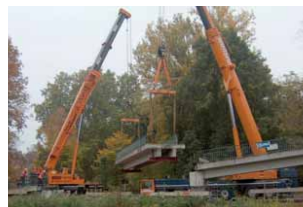
Bauzeitlicher Abbau des Domgartenstegs
