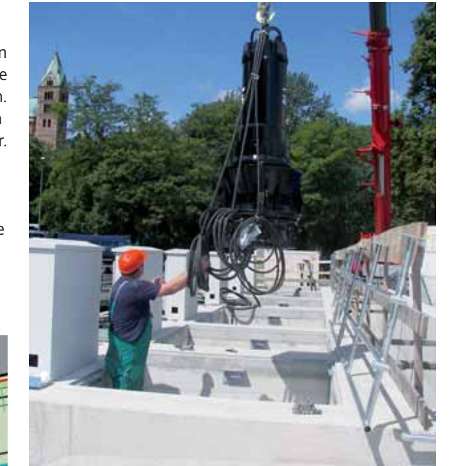
Einbau der Pumpen in die Pumpenkammern
