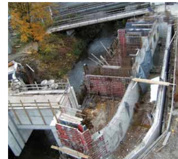
Pumpwerk Speyerbach mit Absperrbauwerk während der Bauphase
