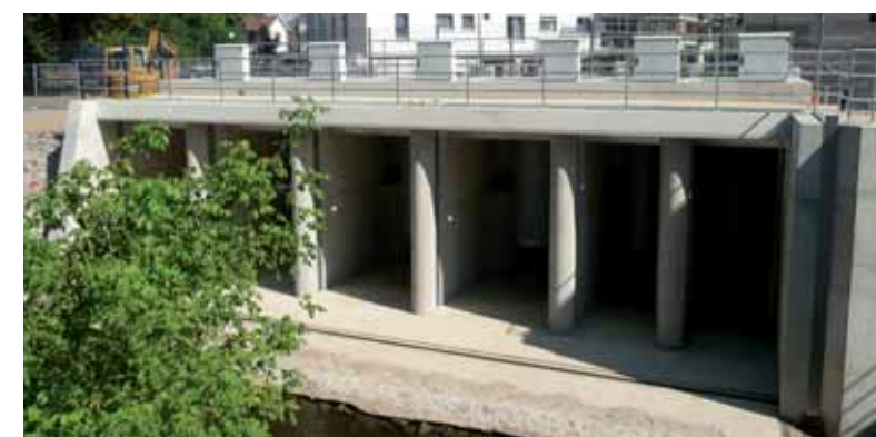
Blick in die Pumpenkammern vor Einbau des Rechens
