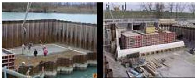
Abbildung A3.3: Anlegen der Baugrube für Bauwerk 64 (Landseite)
