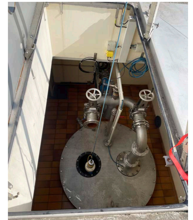
Kamerabefahrung eines Schutzbrunnens
