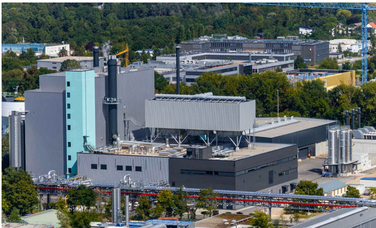
Neues Biomasseheizkraftwerk der Fa. Boehringer Ingelheim Pharma GmbH & Co. KG
