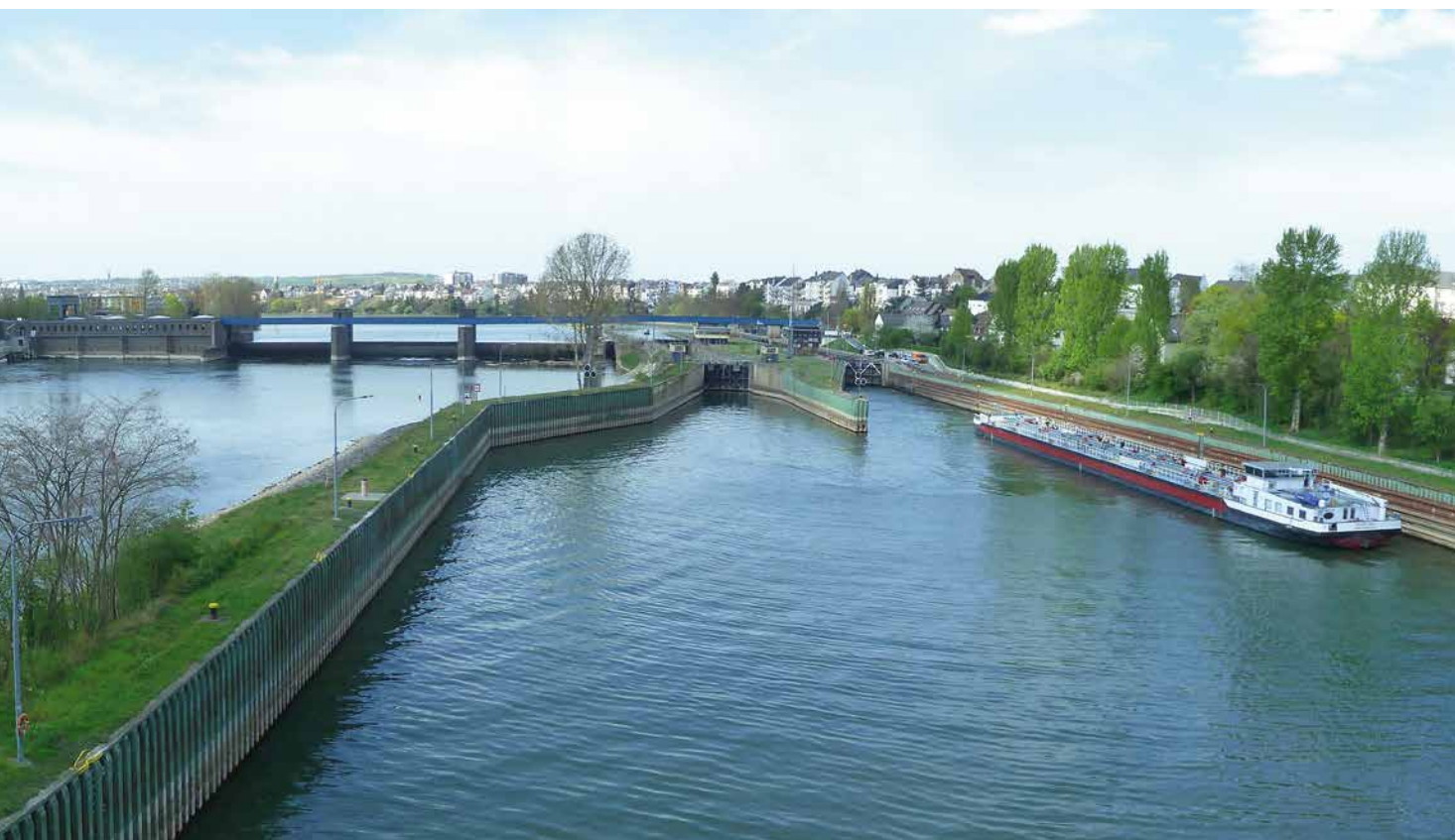
Staustufe Koblenz in der Mosel; Urbane Bebauung, verkehrliche Infrastruktur, Wasserkraftnutzung und Schifffahrt sind maßgeblich für den Gewässerausbau Quelle: Stephan Naumann
