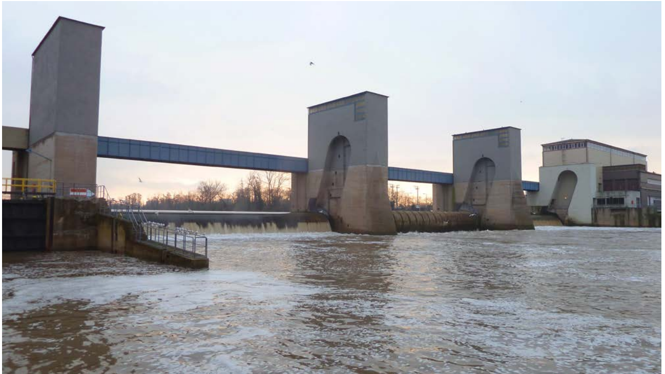
Wasserkraftanlage am Main (Eddersheim).
