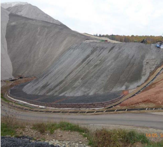
Bodenabdeckung einer Salzhalde.
