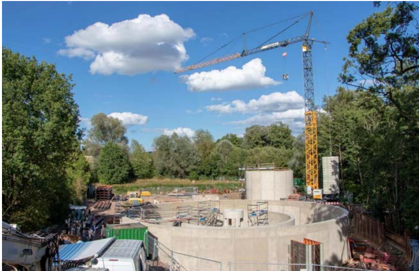
Neubau Kläranlage Erfweiler-Ehlingen.
