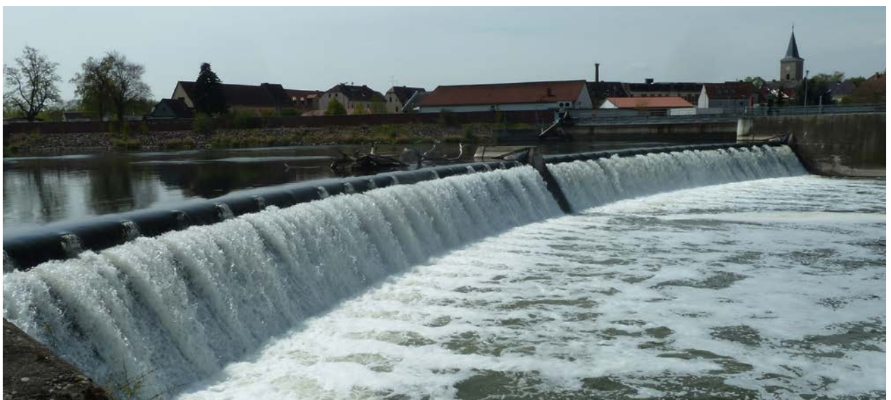
Wehranlage in der Mulde bei Raguhn.
