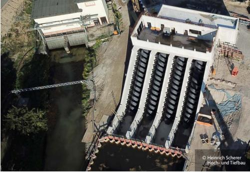
Altes Schöpfwerk vor dem Rückbau und neues Bauwerk in der Bauphase mit eingebauten Schneckenpumpen.
