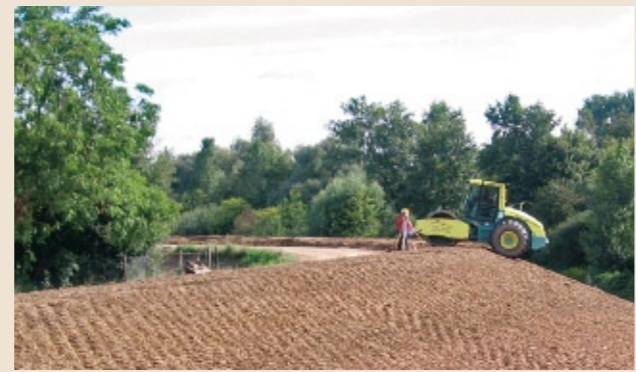
Verdichten der wasserseitigen Deichböschung
