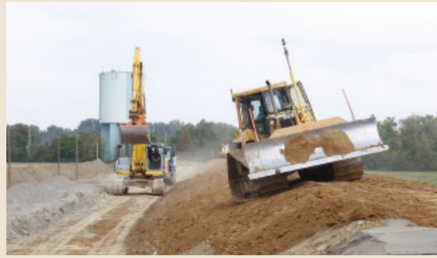
Profilieren des Deichkörpers
