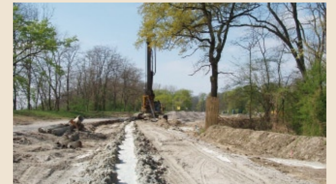
MIP-Wandtrasse nach Ausführung
