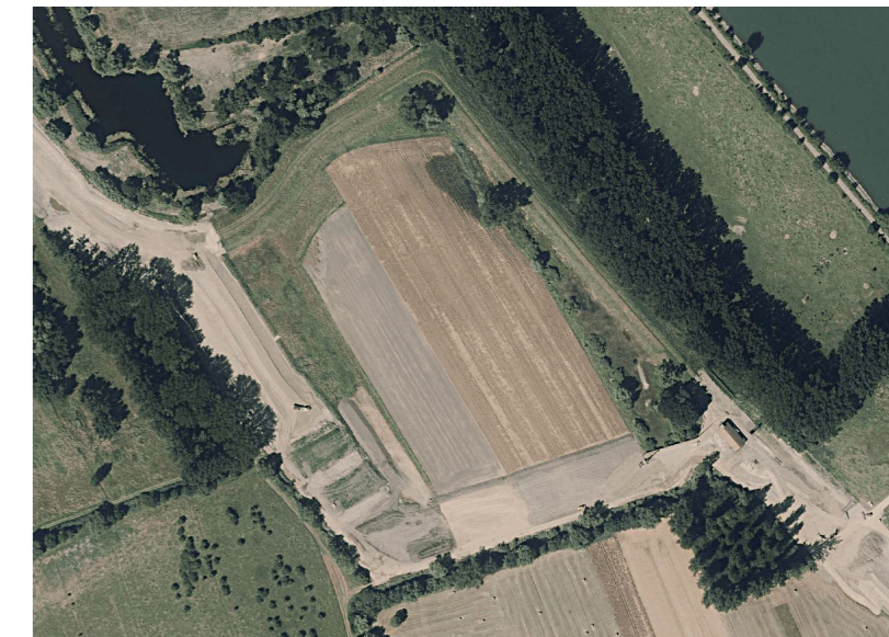
Luftbild mit Deichrückverlegung (im Bau) und Lorenzwiese
