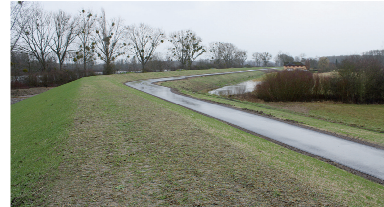
Teilabschnitt III - IV, Neuer Deich mit Bermenweg
