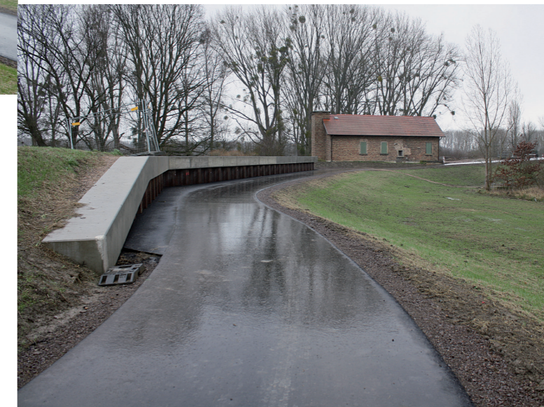
Schöpfwerk Guntersblum mit Spundwand
