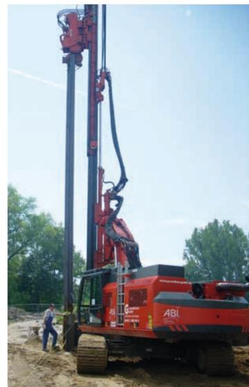
Einbringen von Spundwänden am Hochwasserpumpwerk
