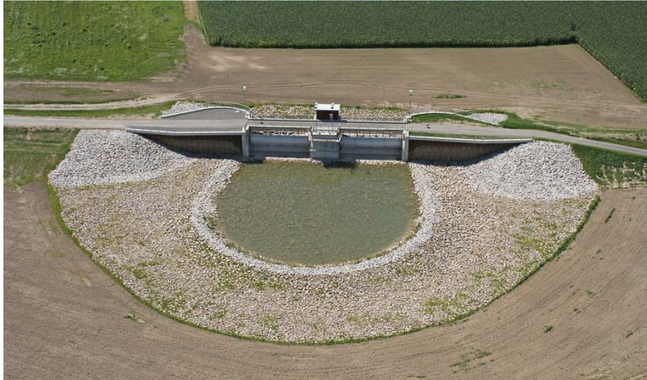
Ein- und Auslassbauwerk zur Flutung der HWR W/J
