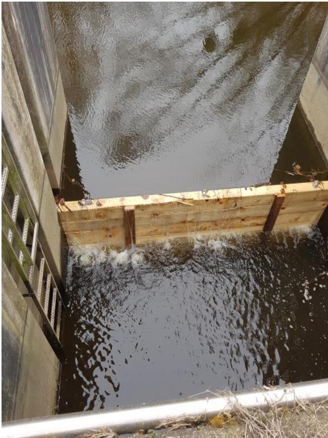
Montiert wurde das Überfallwehr in die Aussparungen der Seitenwangen des Sielbauwerks auf der Seite zum Wörther Altwasser.
