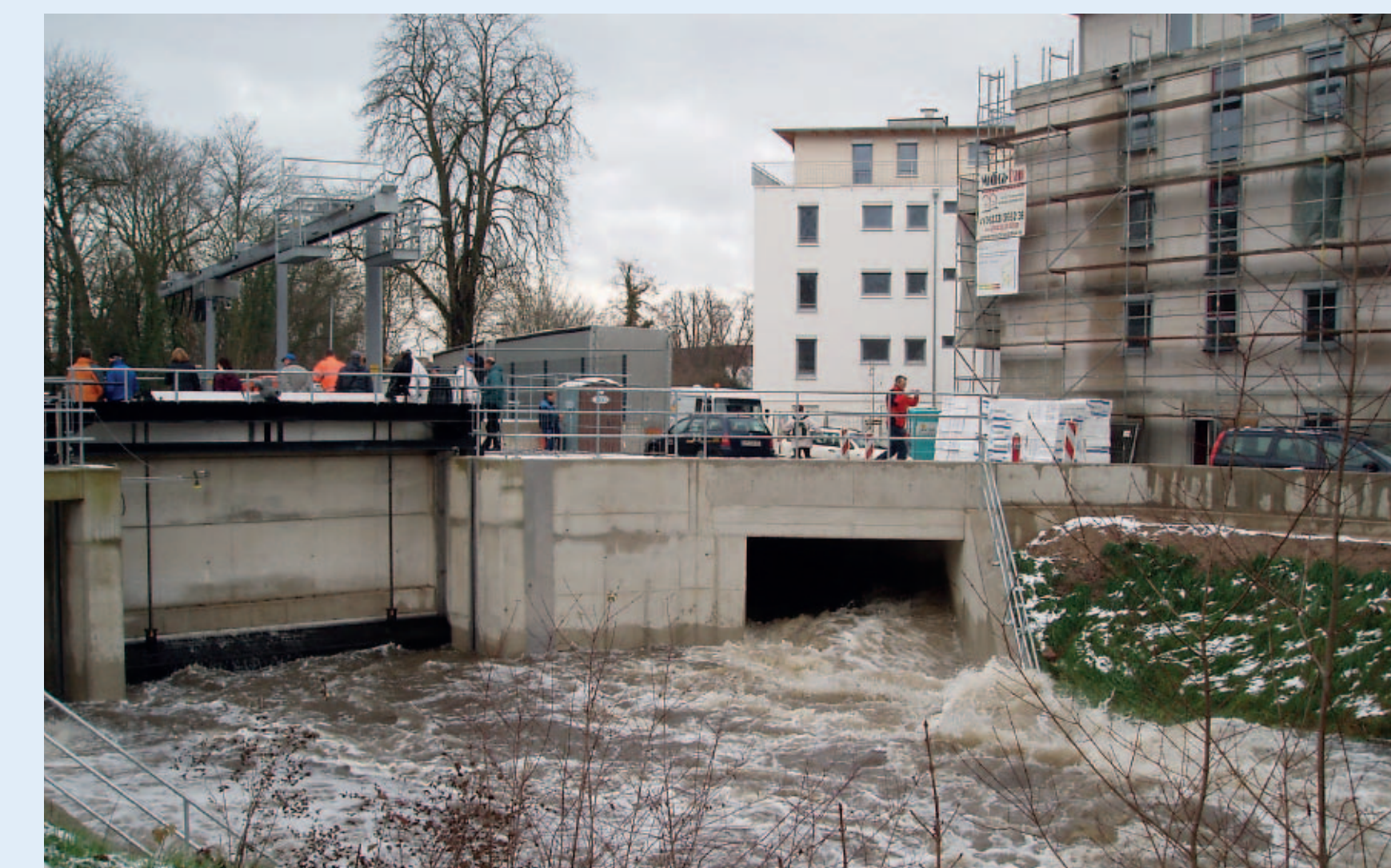
Pumpenauslauf des Schöpfwerks Speyerbach, die Schütztafel ist geschlossen
