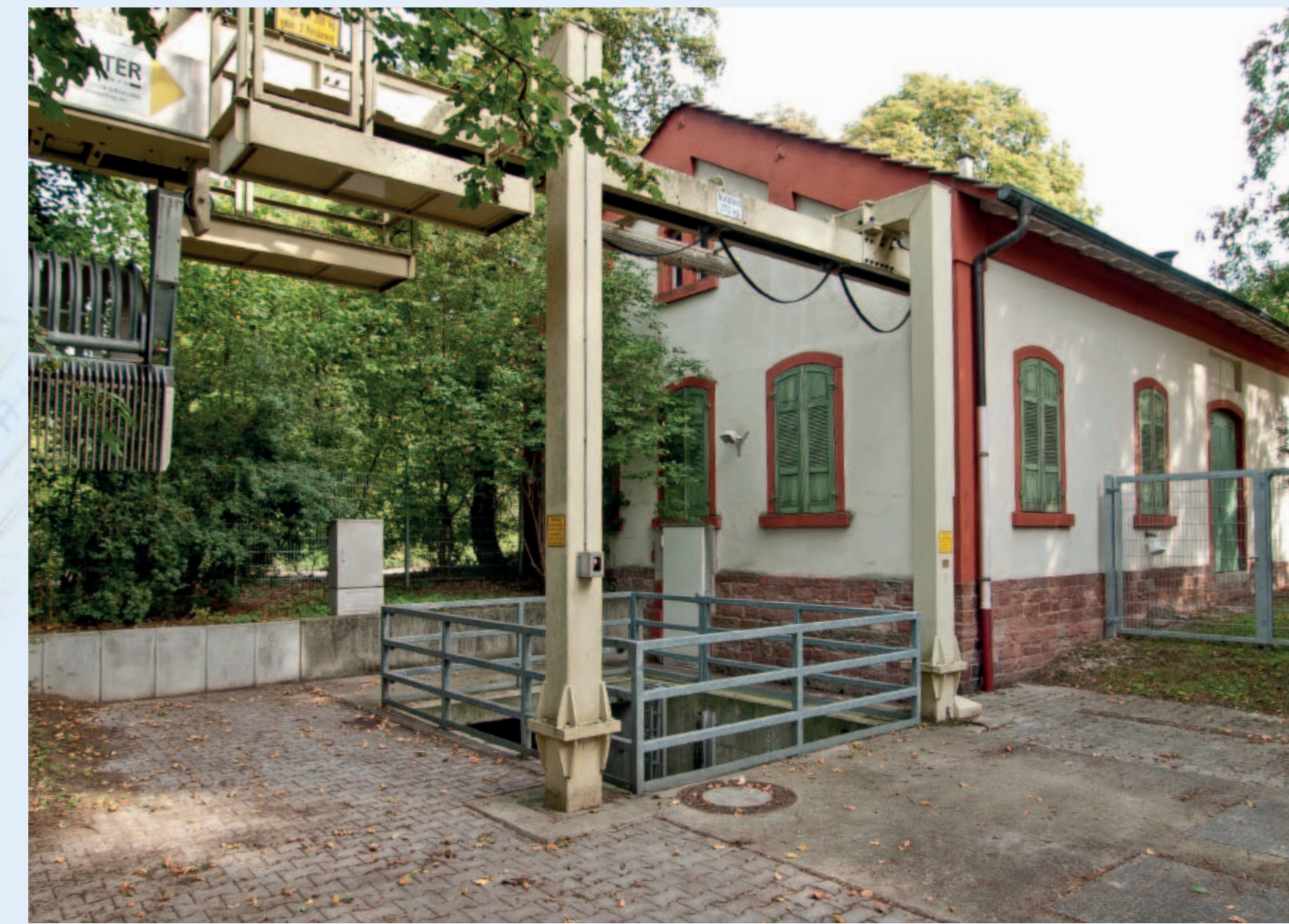
Betriebsgebäude Schöpfwerk Speyer Süd mit automatischer Rechenreinigungsanlage am Zulauf Fischergraben
