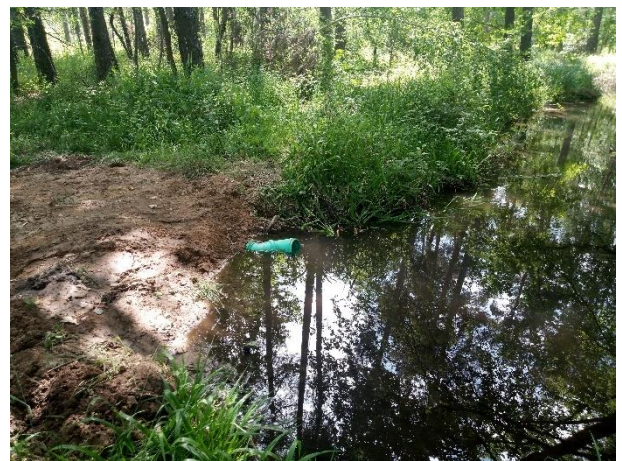
Einfaches Regulierbauwerk im Neustadter Altbach südwestlich von Haßloch (4)
