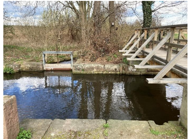
Abzweig Kandelgraben vom Speyerbach (14)
