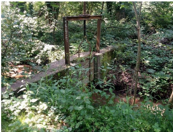
Früheres Regulierbauwerk im Erbsengraben (3)
