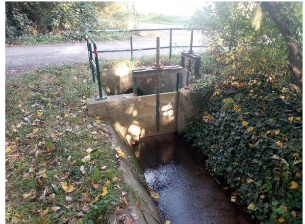
Regulierbauwerk in der Landwehr am Abzweig des Steinbachs westlich Haßloch (2)
