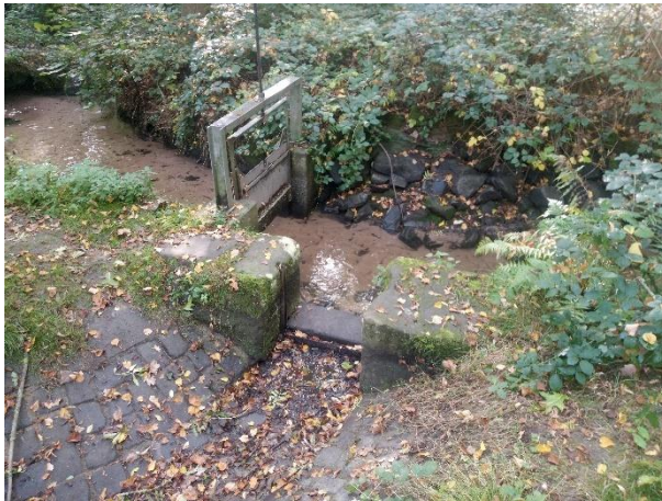
sog. Nutria-Wehr im Erbsengraben, bei Staustellung Beschickung Kahlschlag (1)
