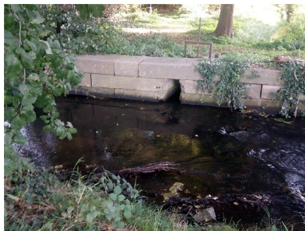
Abzweig Landwehr vom Rehbach (6)
