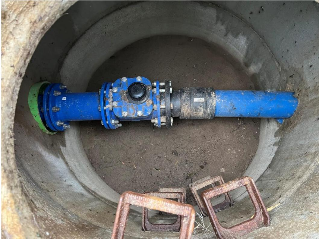
Abb. 6 Mechanischer Wasserzähler - Festinstallation in Schachtbauwerk bei Mecktersheim mit gerader Ein- und Auslaufstrecke; Quelle: envi-systems (2023)
