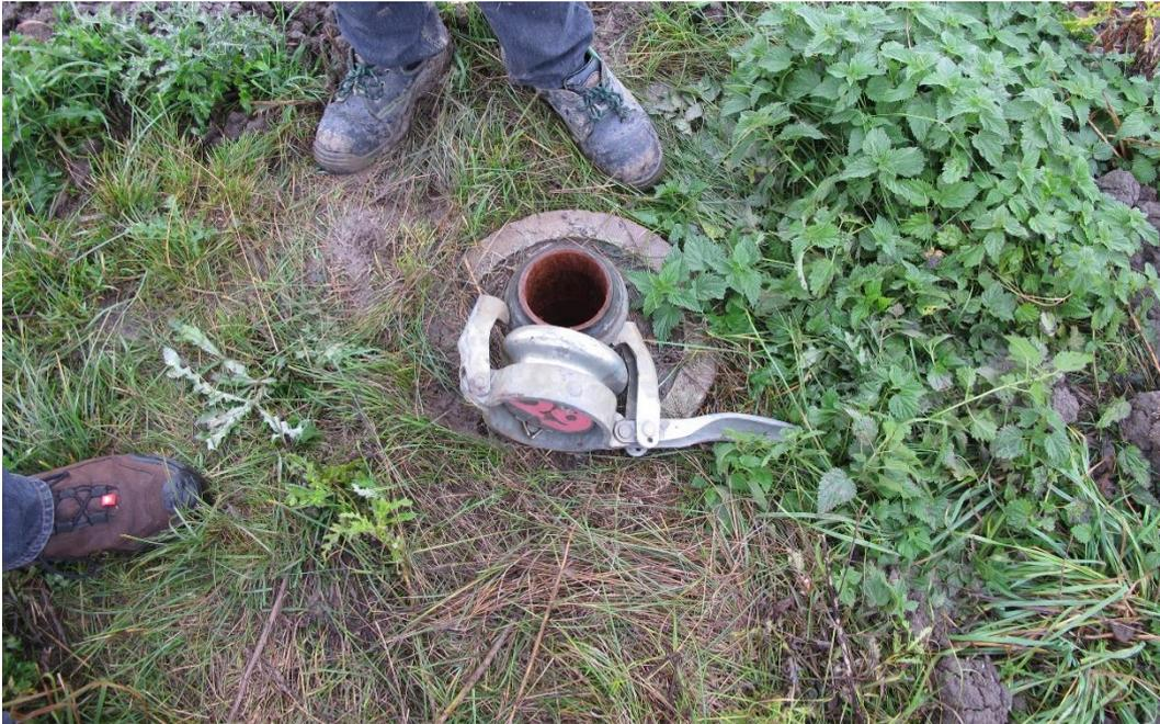
Abb. 1 Brunnenabschluss Saugbrunnen (Ausbau DN 300) mit Saugleitung (DN 100), Übergang auf Schnellkuppelungsrohr
