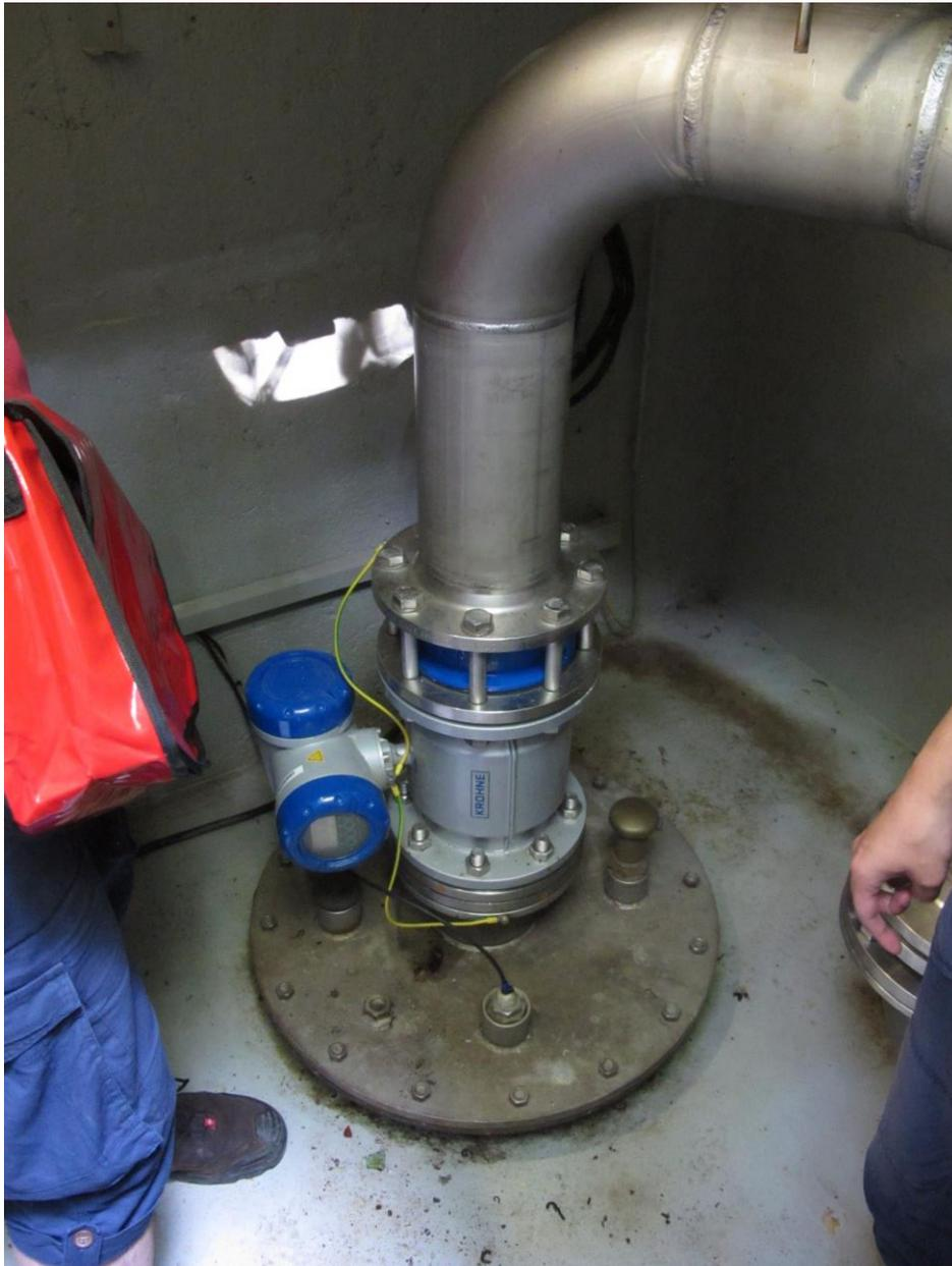
Abb. 7 Digitaler Wasserzähler - Festinstallation in Brunnenschacht bei Groß-Gerau (Quelle: BGS UMWELT 2023)
