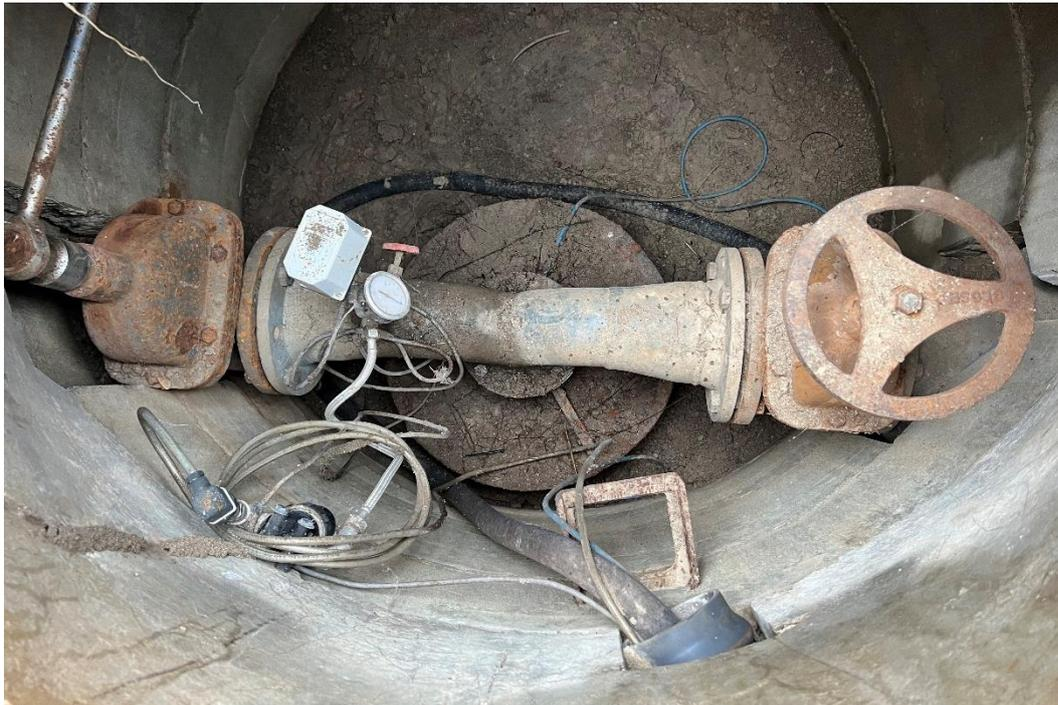
Abb. 3 Brunnen im Schachtbauwerk, Übergang auf 2 Rohrleitungen
