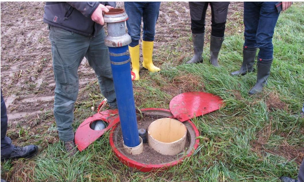
Abb. 2 Brunnen mit doppeltem Ausbau (DN 300 und DN 100)
